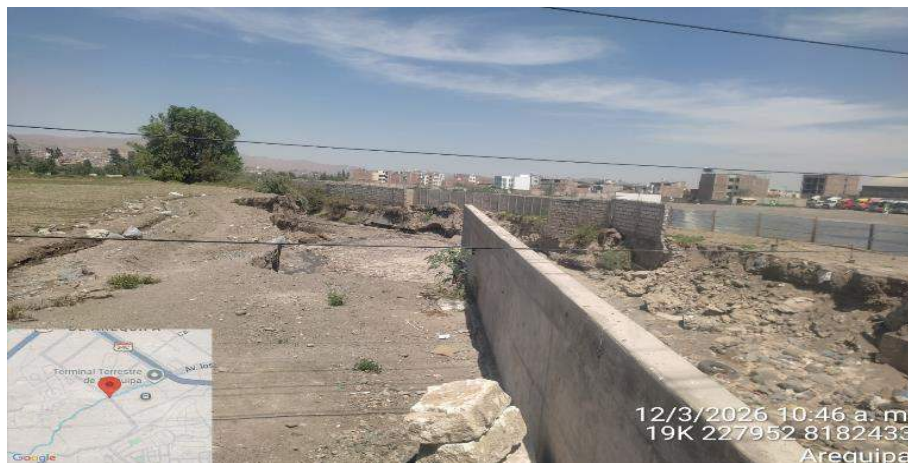
IMAGEN 01: SE OBSERVA LA MARGEN IZQUIERDA DE LA QUEBRADA SIN PROTECCION , ERSOIONADA Y SE REQUIERE DE CONSTRUCCION DE MURO DE CONCRETO ARMADO
